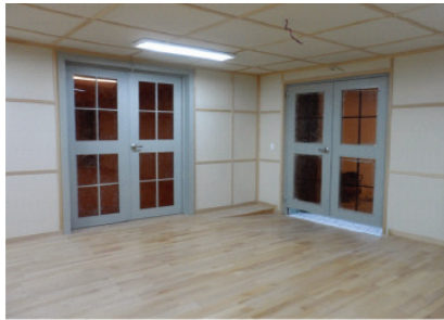
수장고 전용 출입문의 후면부(내부)
